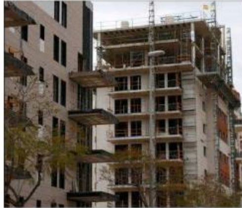
Un edificio en construcción en la ciudad de Castellón. EUGENIO TORRES
