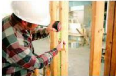
Se observan medidas en un edificio en rehabilitación
